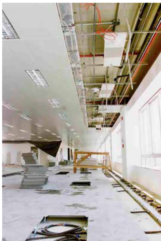
Instalação de forro radiante
