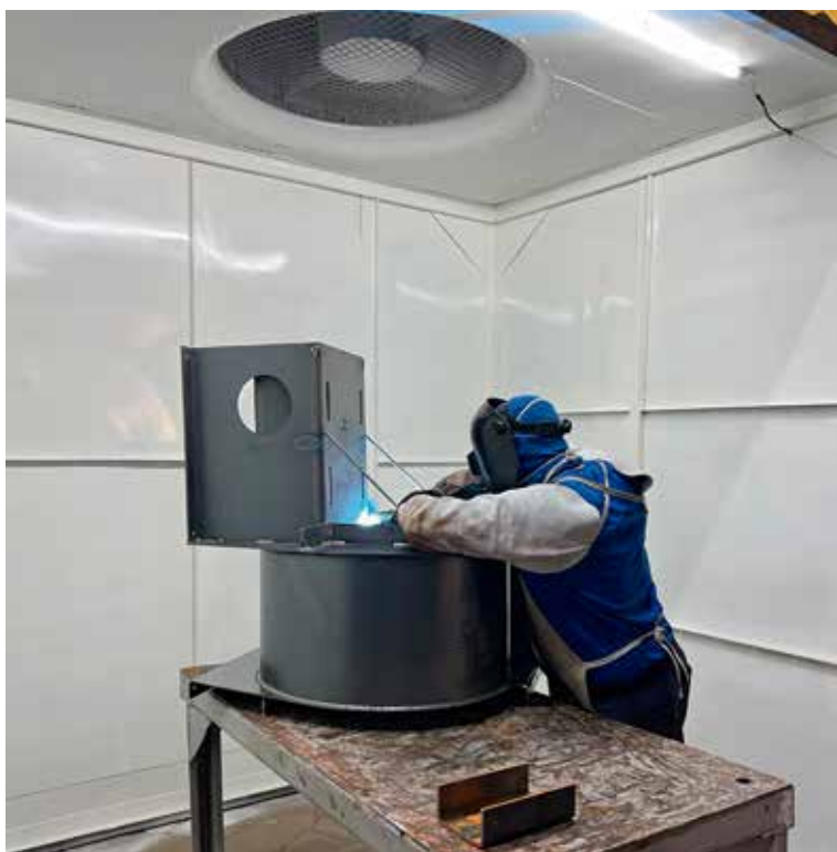
Ventilação localizada em ambiente industrial (Divulgação: Projelmec)
