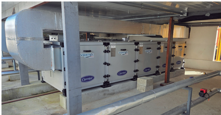
Casa de máquinas
